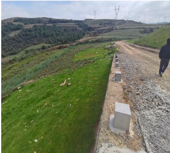
项目升压站外边坡
