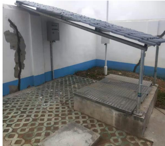
项目升压站污水处理设置
